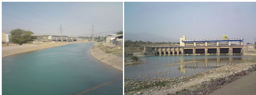
Рисунок 2.3. – Головной регулятор на ПК 0 + 00 Паркентского магистрального канала
