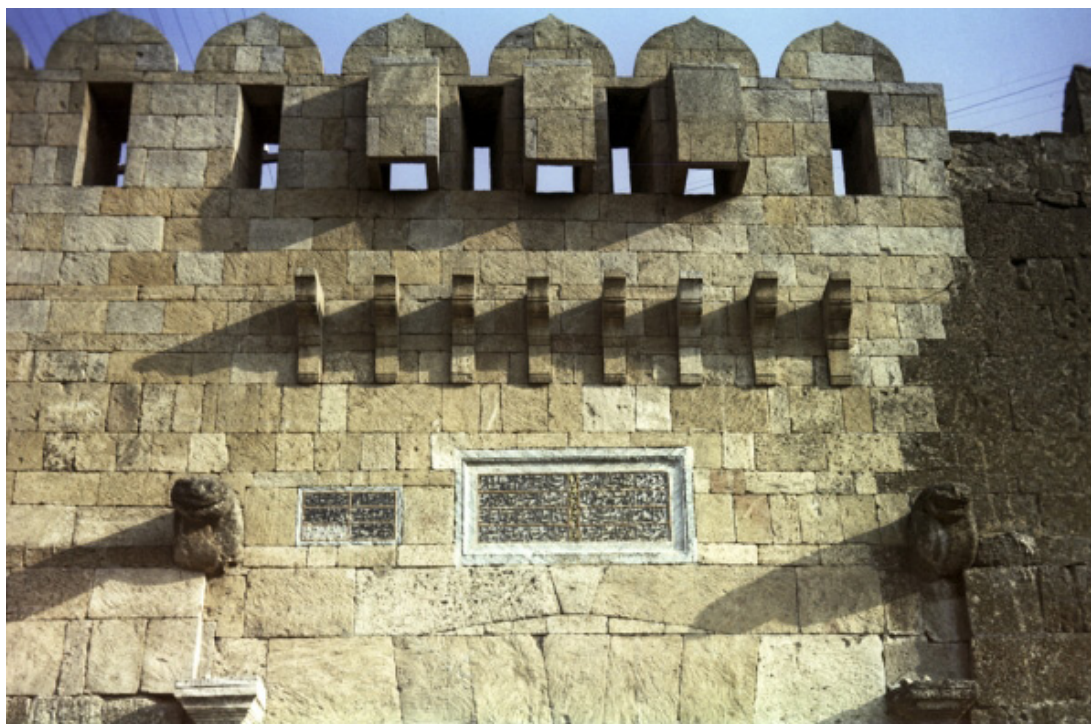
Ворота северной городской стены. Кырхляр-капы. Вид с фасада
